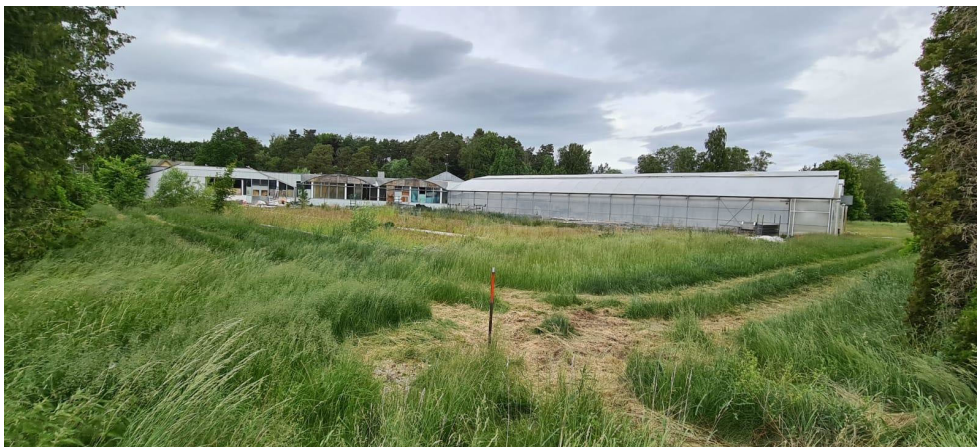
Befintlig bebyggelse, vy från korsningen Idrottsvägen/Odlaregatan.
