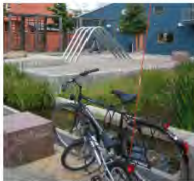
Dagvattenhantering i kombination med växlighet. Detta kan vara ett lämpligt sätt att fördröja avrinningen till det allmänna ledningsnätet och samtidigt få ett tilltalande gröninslag i stadsmiljön.
