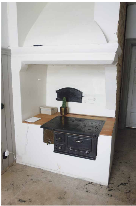
Järnspis med murad kåpa på bottenplan.
