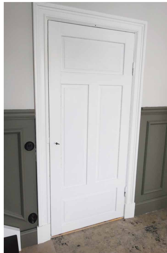
Samtliga ursprungliga spegeldörrar med profilerade foder.
