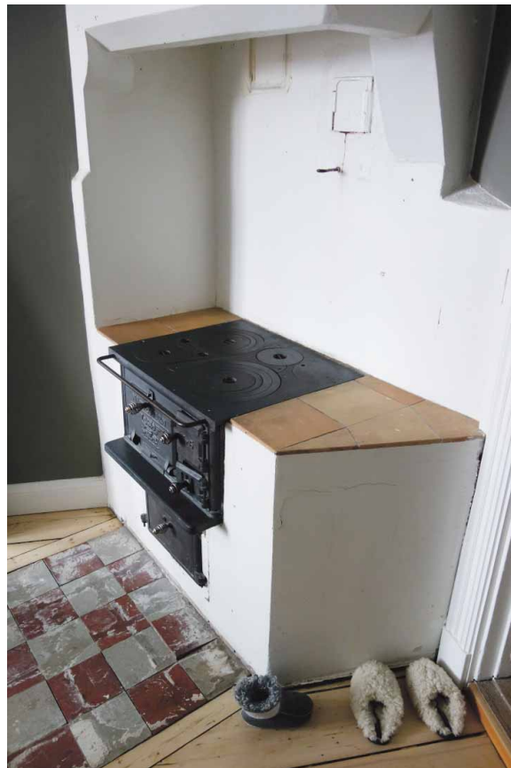
Järnspis med murad kåpa i tidigare lärarbostad på övre plan. Äldre cementklinker på golv.
