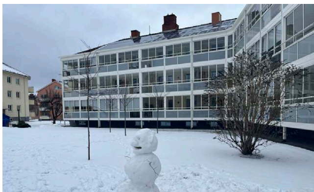
Kvarteret Fiskmåsen med förvanskade fasader till följd av inglasade balkonger och solpaneler på tak.
