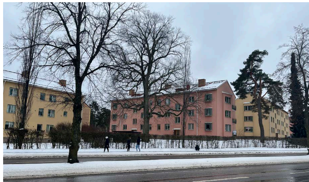
Smalhus i kvarteret Informatorn.
