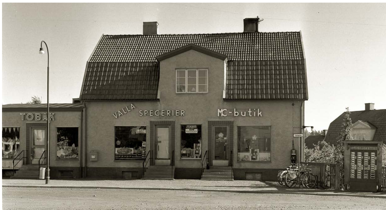
Valla specerier på Vallaplan, uppskattning 1950-tal. Byggnaden har tillbyggt åt öster och fasaden har putsats. Källa: Digitaltmuseum.
